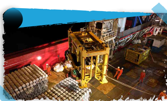
國內首次深水海管堵漏海上實戰演練
